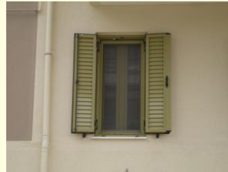
Τοιχοποιία Νοτιοδυτικής όψης
